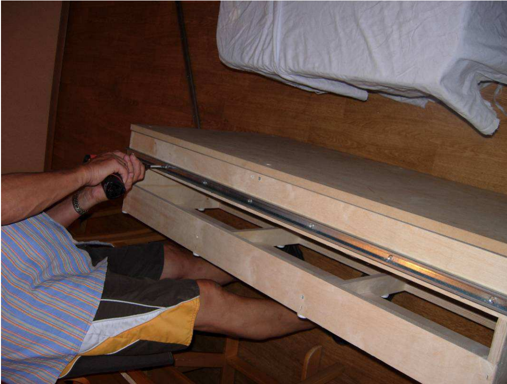
Anbringen der Führungs- schienen links und rechts vom Tisch
